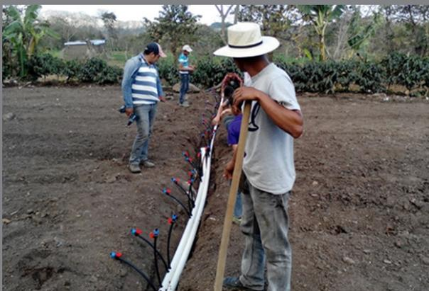
A work crew installing the main line of a drip irrigation system. / Cuadrilla de trabajo instalando la línea principal de un sistema de riego por goteo.
