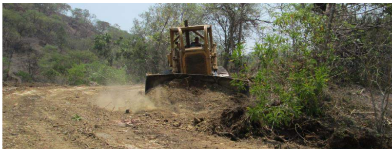
Widening of road to create access for farmers to transport their produce. / Ampliación de camino creando acceso para que los productores puedan transportar sus productos.
