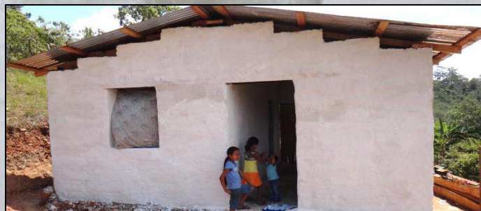
Home after being plastered and whitewashed with lime / Casa después de ser revocada y pintada con cal
